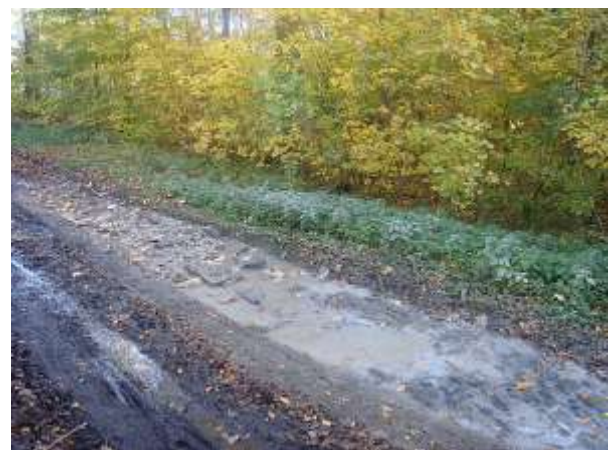
Og så må skaderne lappes, her med bygningsaffald. Det glæder ikke skovgæsten.
