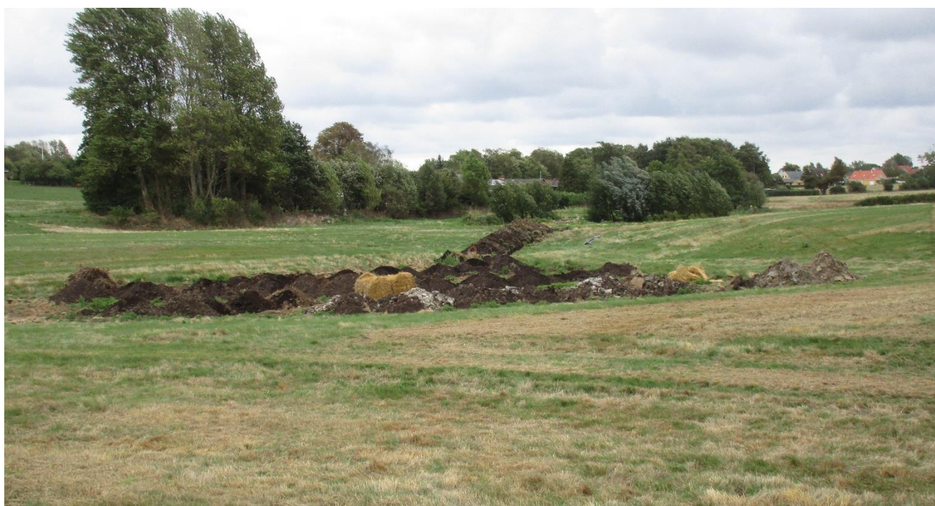
Men det gjorde der så i 2018. Et omfattende drænsarbejde udføres i slutningen af august. Her den 24. august 2018.
