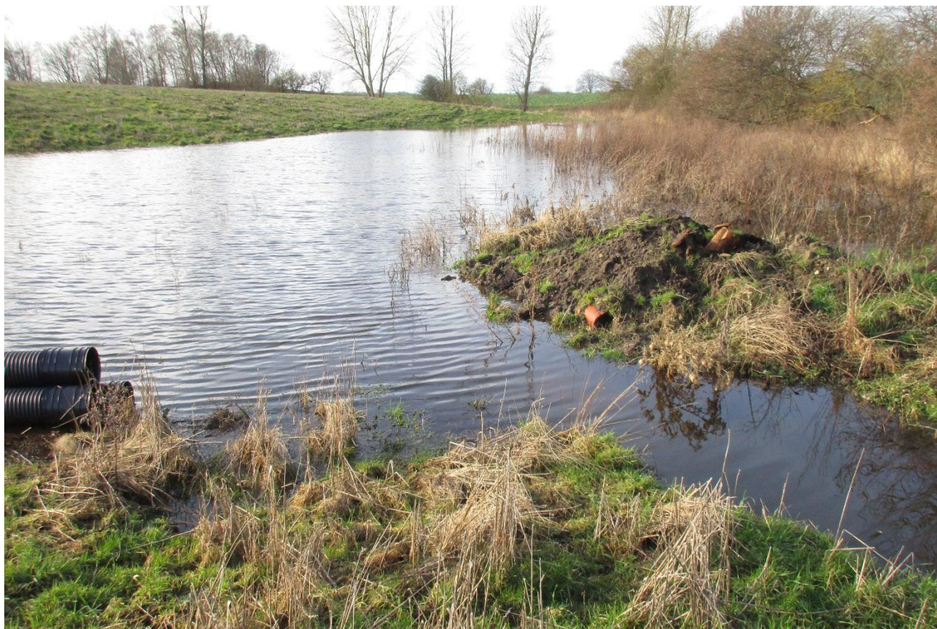
Et større drænsarbejde blev iværksat i M 3's nordlige del, her 30. januar 2018..
