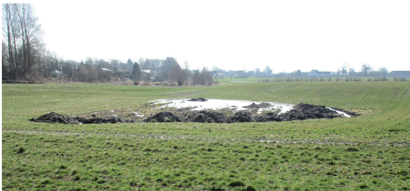
Drænsarbejde påbegyndes i en lavning mod øst i M 5. Foto: 21. marts 2017. Der blev dog ikke foretaget yderligere det år.
