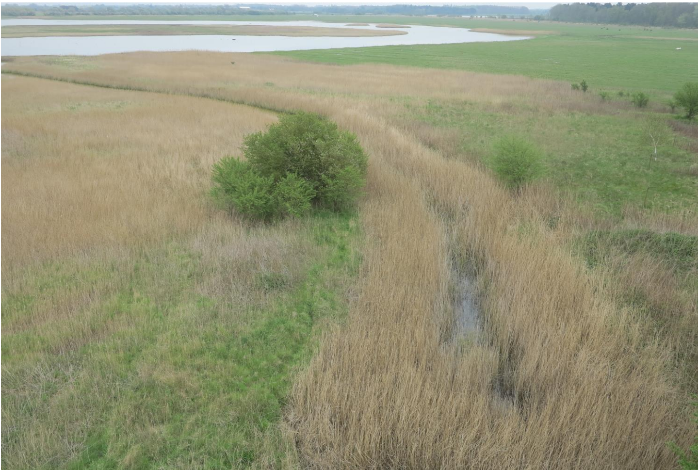
Den gamle afvandingskanal, som førte til den hollandske pumpemølle har nu været ude af funktion siden 1960'erne og er stort set groet til med Tagrør. I dag løber vandet fra Reservatet ud i pumpekanalen via et udløbsbygværk, hvorefter det pumpes ud i Lillebælt via den elektriske pumpestation. På fotoet ses ligeledes fine afgræssede strandenge op til den vestlige del af Lagunen. I lagunen ses de "lådne" strandenge, som foreslås renoveret ved et genopretningsprojekt, så det blå bånd kan genskabes. Foto: Kurt Due Johansen.
