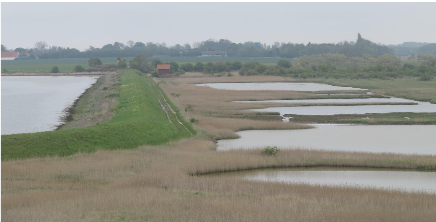
Den elektriske pumpestation fra 1960'erne ved Reservatet. Foran pumpestationen ses havdiget og digegravene, alt sammen kulturhistoriske elementer. Foto: Kurt Due Johansen.
