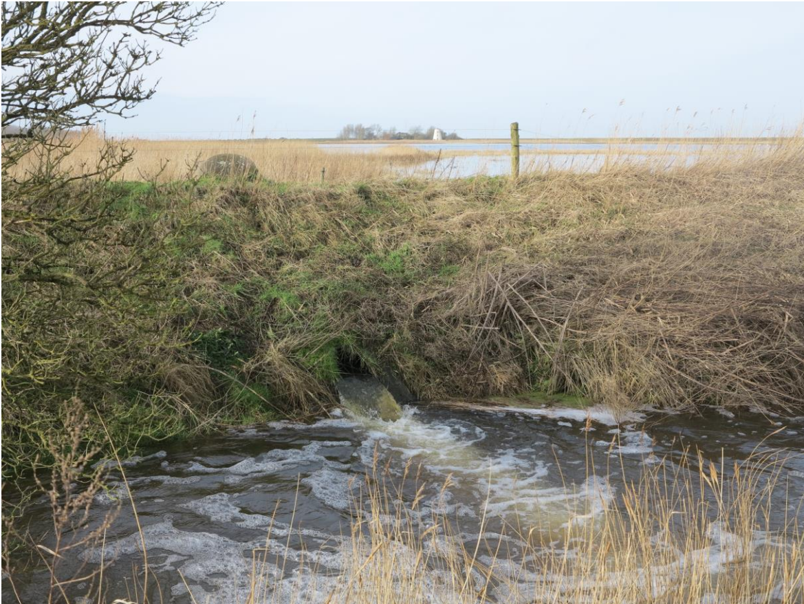
Udløbsbygværket fra Reservatet fører til pumpekanalen, hvorfra vandet pumpes ud i Lillebælt via en elektrisk pumpestation: Foto: Kurt Due Johansen.
