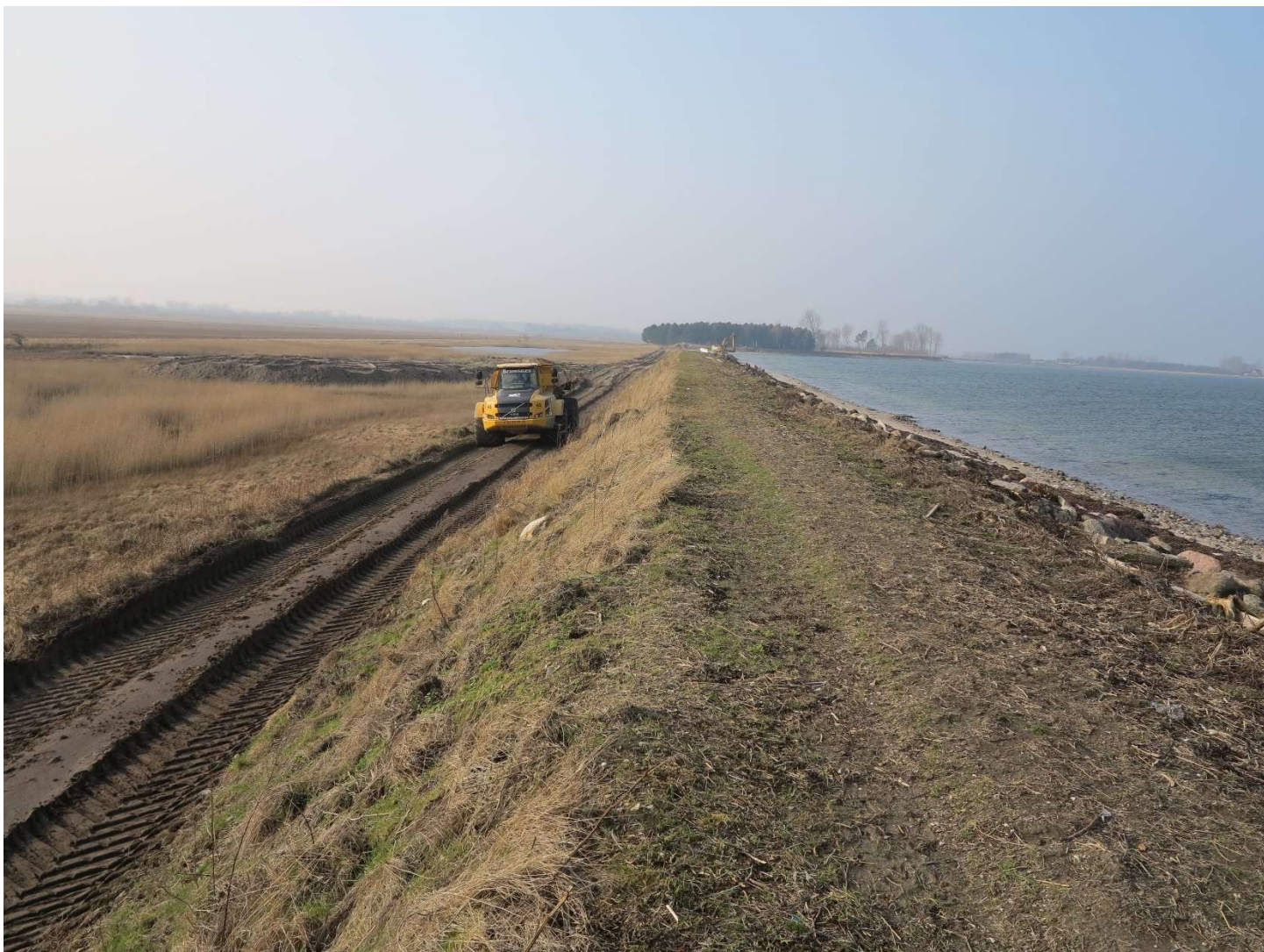
Der arbejdes på uddigningen mellem Lindholm og Langø. Uddigningen nærmer sig ..... Foto: Kurt Due Johansen.
