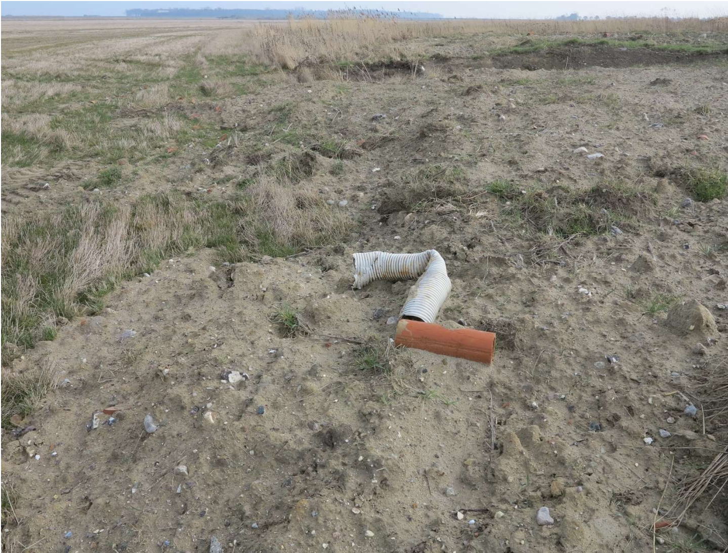
Gyldensteen Inddæmmede Strand blev efter de store afvandringsarbejder 1959-60 drænet. På fotoet ses hvordan. Først med brændte ler dræningsrør, herefter med drænrør af plastic. Foto fra Gyldensteen Inddæmmede Strand. Kurt Due Johansen.
