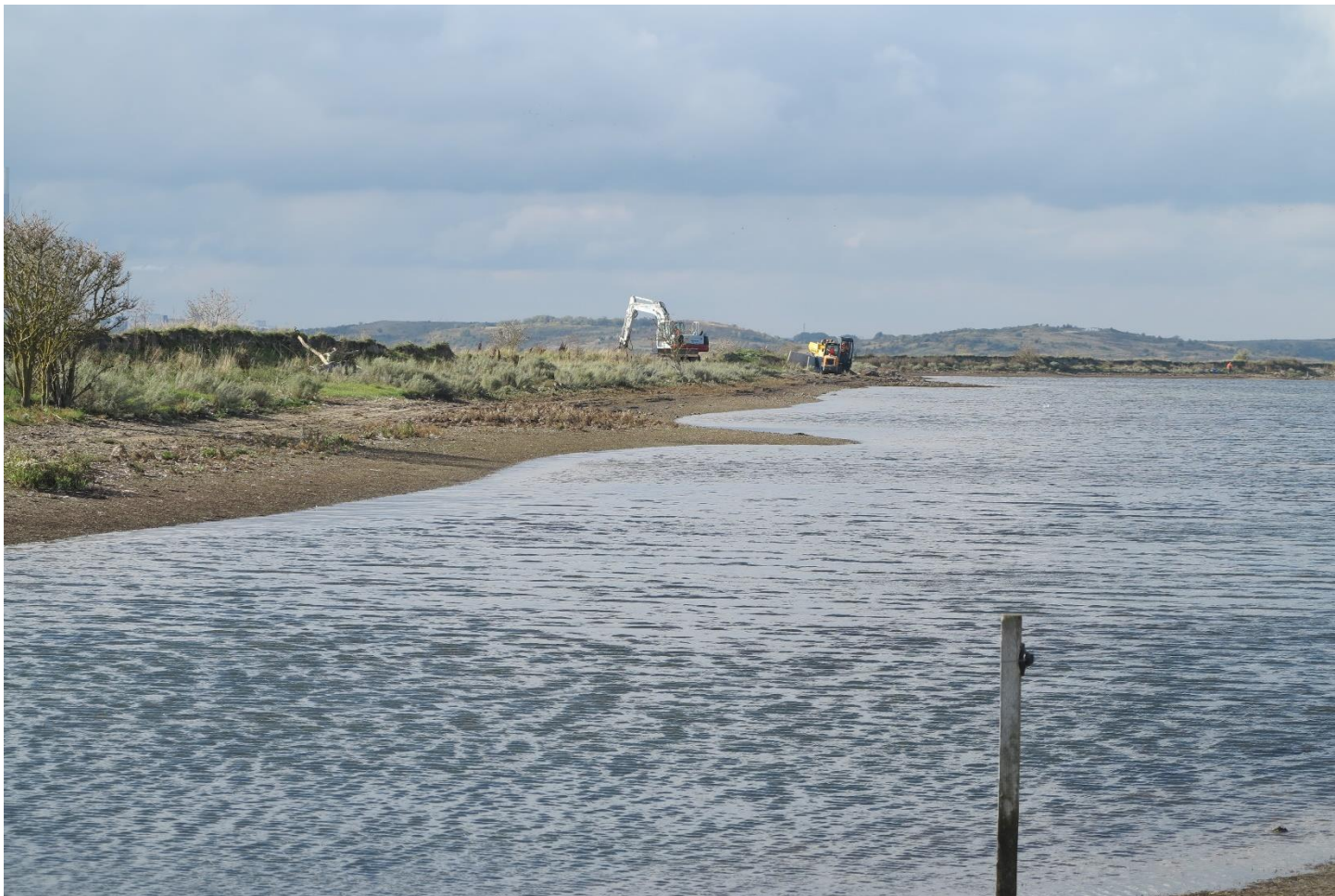
Der arbejdes ved syddiget i forbindelse med reparationsarbejderne på slusen ved SV-området i efteråret 2020. Det var nødvendigt for overhovedet at komme over på SV-området, som jo er en ø. Foto: Kurt Due Johansen.
