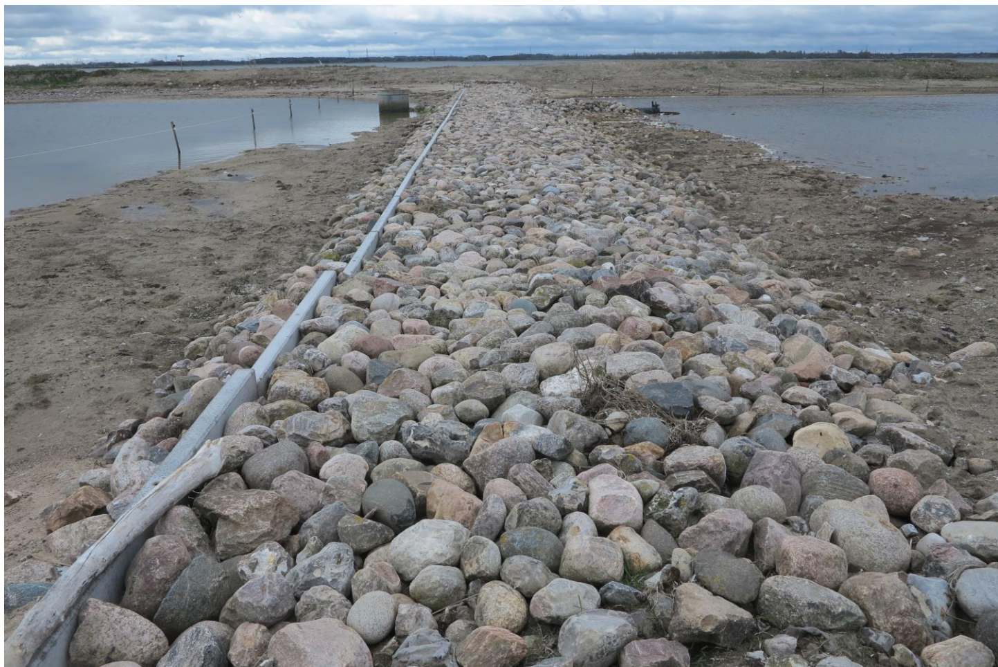
Figur 9. Fra SV-området i det sydvestlige hjørne af Vigelsøs Kystlagune. Området er en inddæmning på 4 hektar, hvor der er etableret kunstige strandenge på dæmningerne. På fotoet ses den stenkædte dæmning mod vest, som indeholder et udløbsbygværk. Når højvandet i Kystlagunen overstiger +1 meter, løber vandet ind i det inddæmmede område, hvorefter det ved lavvande forlader området via overløbsbygværket, som ses ca. midtfor, bagerst i billedet. Foto: Kurt Due Johansen.
