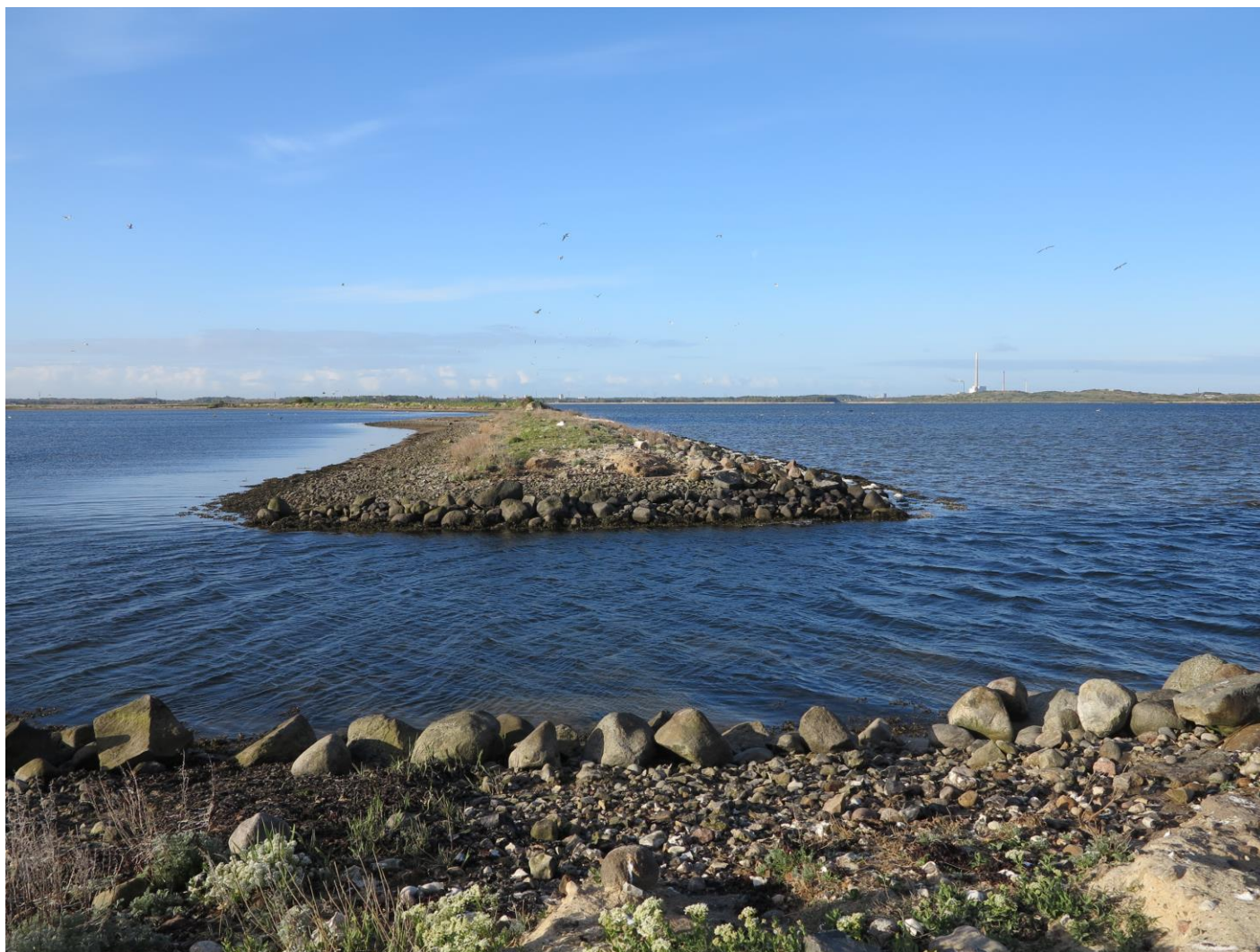
Figur 12. Den kunstige ø, som blev skabt ved at etablere ét hul mere i vest-diget, end det hul, som stormen Bodil havde lavet i december 2013. Hullet i diget fungerer nu som ind,- og ud-strømningshul for tidevandet, som skifter retning 2 gange om dagen. Foto: Kurt Due Johansen.
