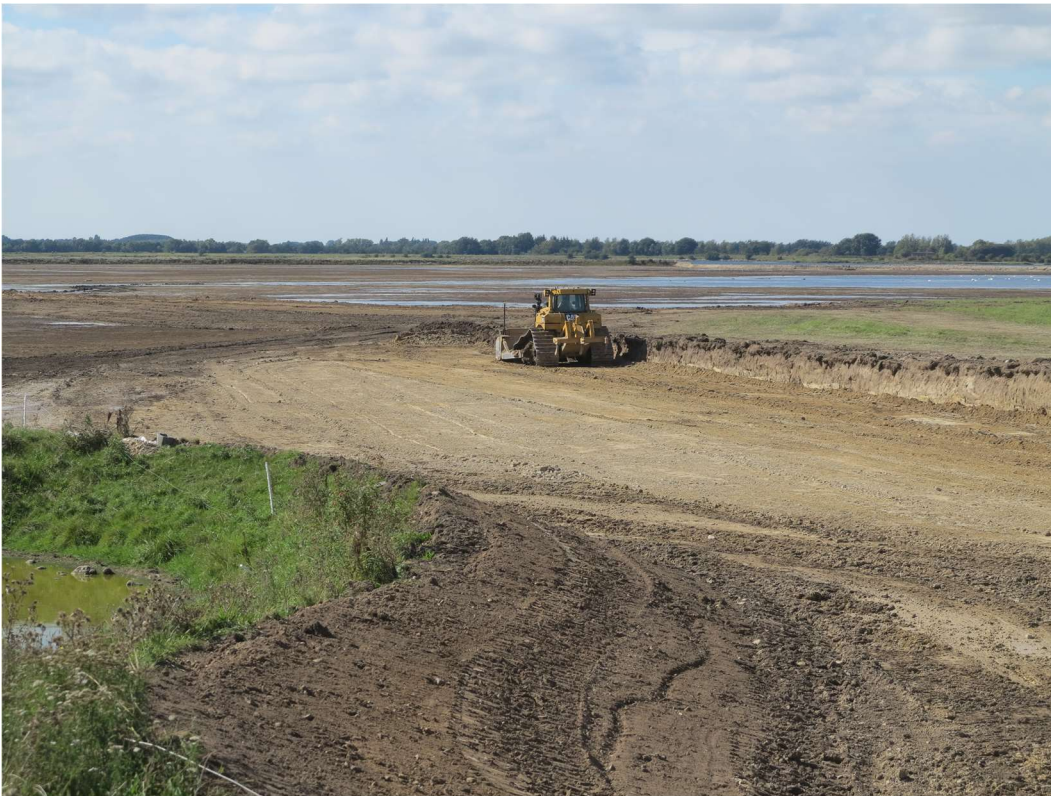
Figur 25. Der etableres kunstige strandenge ud for halvøen Østerhoved i 2016. Fotoet der er fra 06.09.2016, viser, hvordan de kunstige strandenge, som er tættest på halvøen, dozes ud i terrænet, hvorimod de strandenge der fremtidigt kom til at ligge længere væk fra den oprindelige Østerhoved, blev skabt ved at jord blev kørt ud i terrænet med en dumper. Foto: Kurt Due Johansen.
