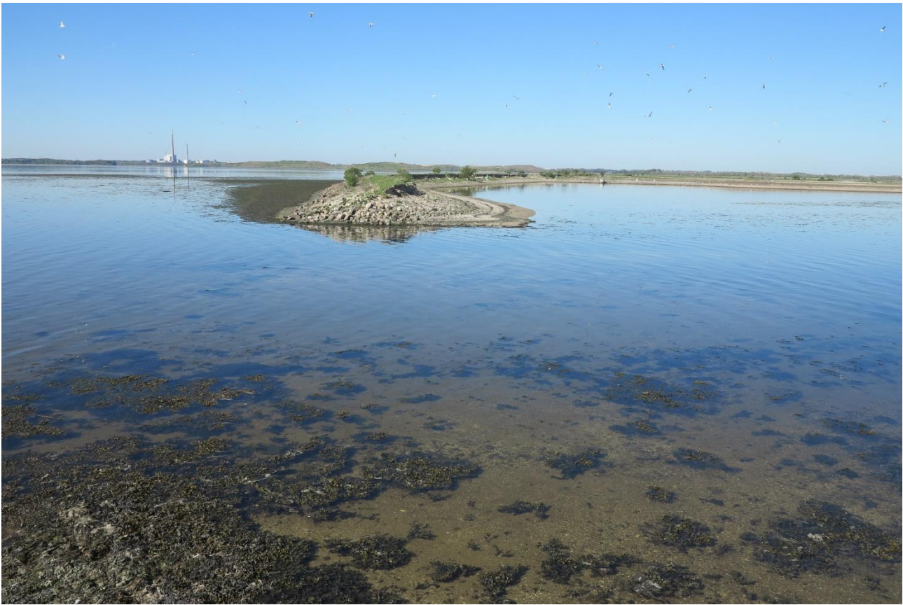
Foto af hullet i syddiget. I baggrunden ses Fynsværket. Foto: Kurt Due Johansen.
